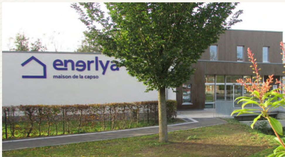
Enerlya, Maison de la CAPSO - Source : Enerlya
